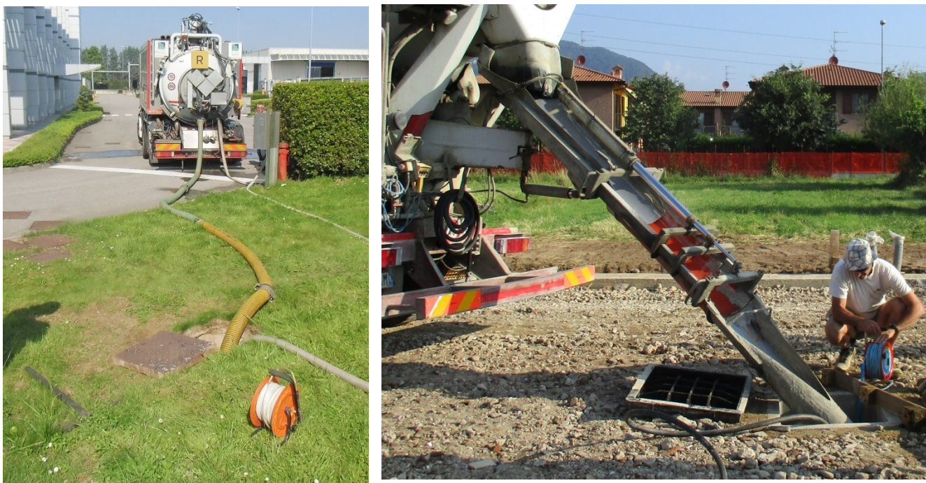
Figura 5: esempi di immissione dell'acqua pulita per l'esecuzione delle prove di percolazione/infiltrazione. A sinistra immissione mediante autocisterna, caso A, e a destra mediante betoniera (caso B).
