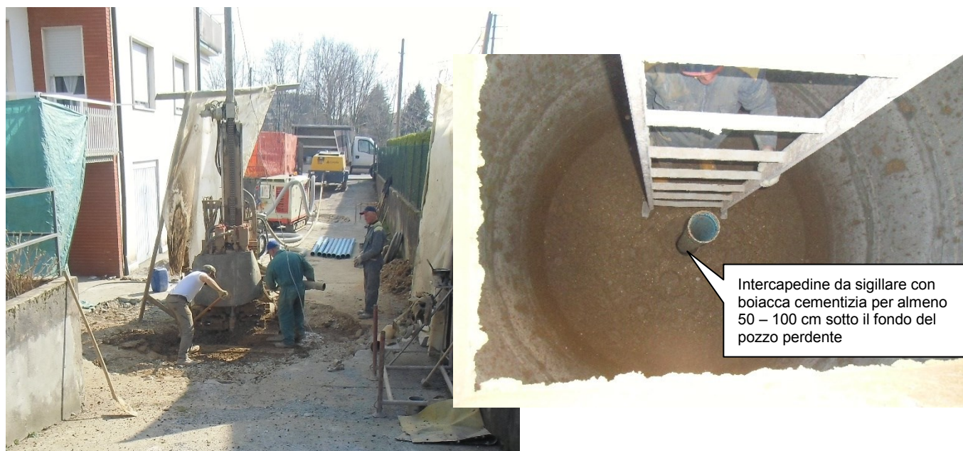
Figura 4: esempi di realizzazione di un dreno profondo in pozzo perdente. A Sinistra la macchina perforatrice posizionata sulla testata del pozzo perdente. A destra dreno ultimato al fondo del pozzo perdente appena ultimata la pulizia e prima della cementazione del foro al fondo.
